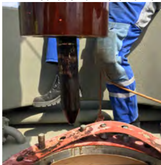
c.) Bei einer vor Ort durchgeführten Demontage der 400-kV- Durchführung eines 333MVA-/400kV- Trafopols wurde wegen thermischer Schädigung am Bolzen/Multikontakt der Ausleitungsbereich mit angehoben und beschädigt. Folgende Bilder: Der beschädigte Bereich wie nach Ausbau Aktivteil im Werk vorgefunden, sowie herunter gefallene Teile davon. Sein Originalzustand wird im Bild ganz rechts gezeigt.
